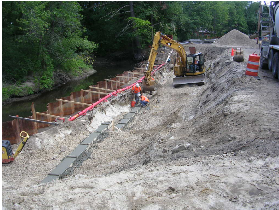
Pouring the MSE wall leveling pad
