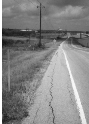
Edge Cracking
