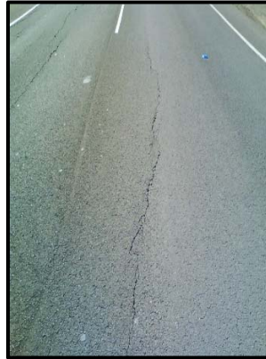
Longitudinal Cracking
